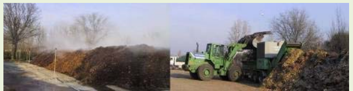
Planta de compostaje de Migas Calientes, Madrid
